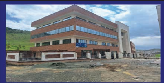
تکمیل و بهره برداری از مجتمع ارتباطات و فناوری اطلاعات استان کردستان با زیر بنای ۷۲۵۸ مترمربع در ۵ طبقه و محوطه ای به مساحت تقریبی ۲۰۰۰ متر مربع
