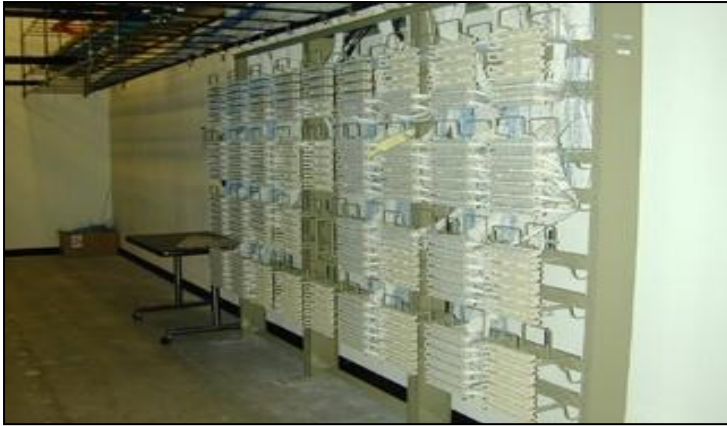
شکل ۶- مرکز MDF شرکت مخابرات
